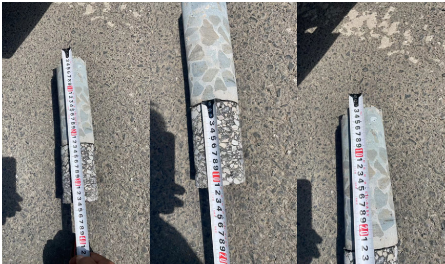
荷青路（取芯完整，面层沥青厚度约为 10cm，水泥板厚度约为 20cm）
