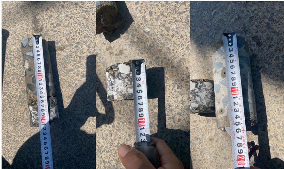
徐李线（取芯完整，厚度为 6cm 沥青+15cm 混凝土）
