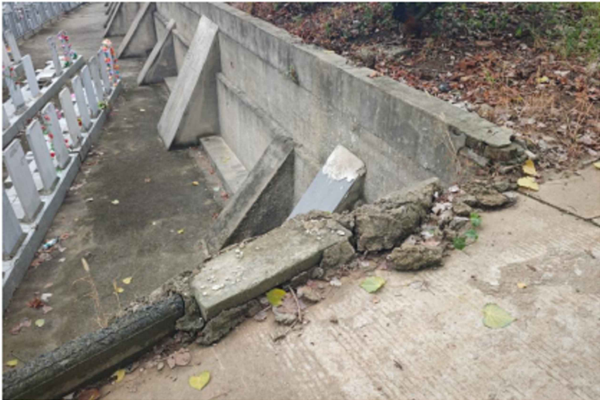
路面、路牙石破损修复
