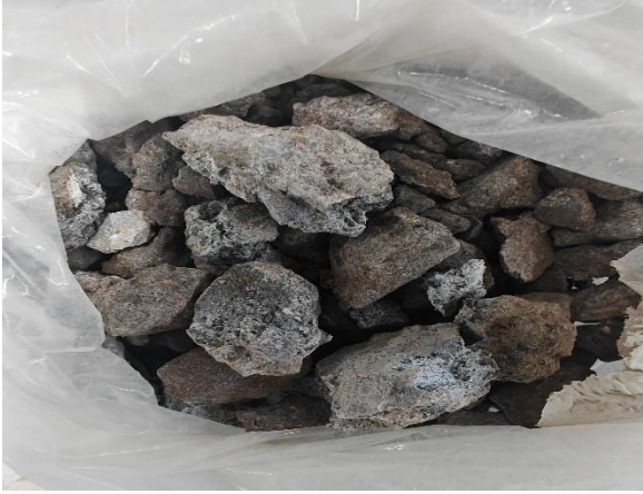
(a) 13#块右箱室铁砂混凝土破损
