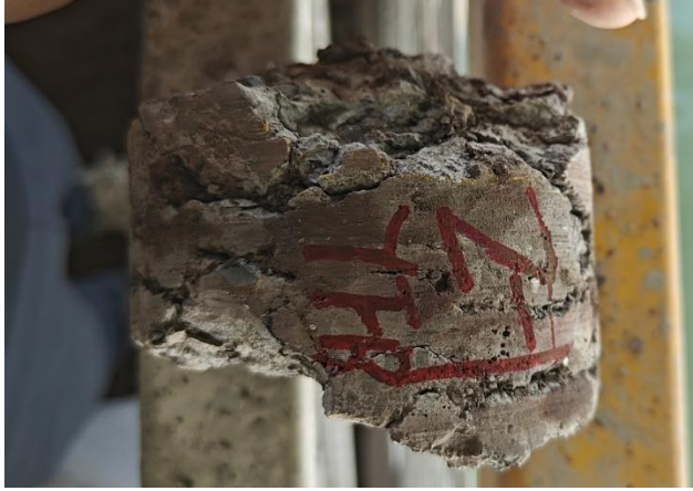
(b) 11#块左箱室铁砂混凝土松散
