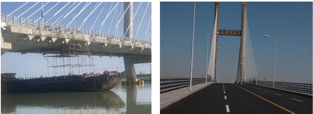
(a) 主桥箱梁粘钢加固 (b) 桥面铺装重新摊铺及护栏更换 图 1.2-4 固城湖大桥 2020 年维修加固照片
