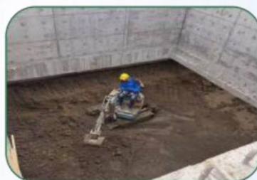
④沉井下沉
