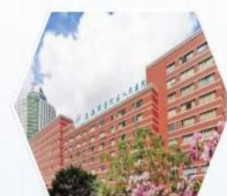
上海市普陀区人民医院
