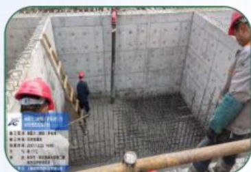
③混凝土施工
