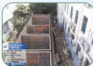
②混凝土施工
