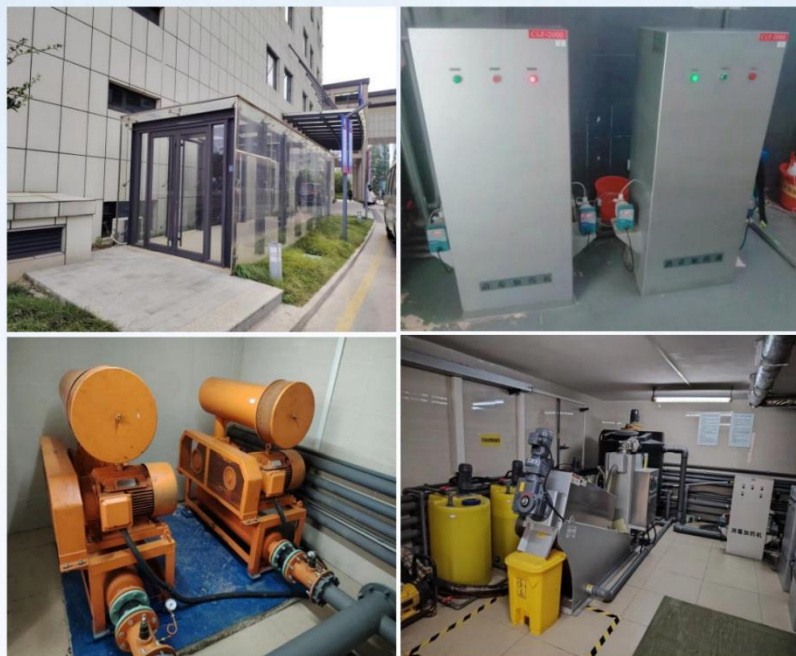
南京医科大学第二附属医院(姜家园院区)污水处理站
