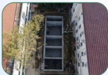
⑤沉井封底完成
