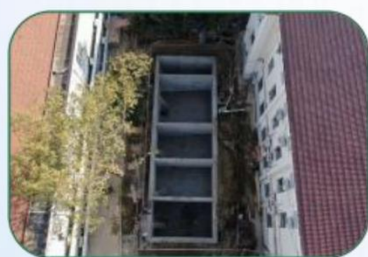
⑤沉井封底完成
