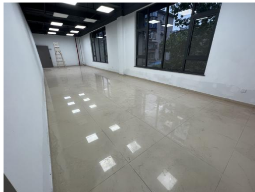
北侧房间墙面（靠近伸缩缝）
